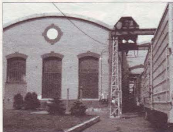
A lokomotívszerelő műhely felújított (módosított) tetőzettel 1984-ben
