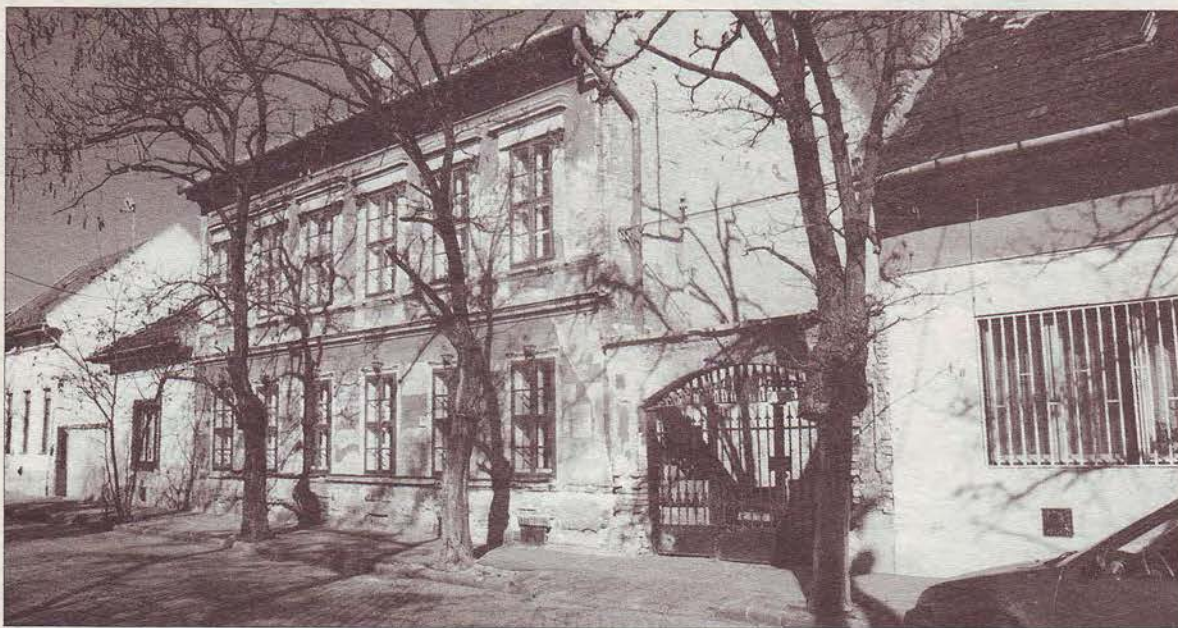
Az Illek Vince u. 14. sz. alatti ház utcai homlokzata és kapuja
