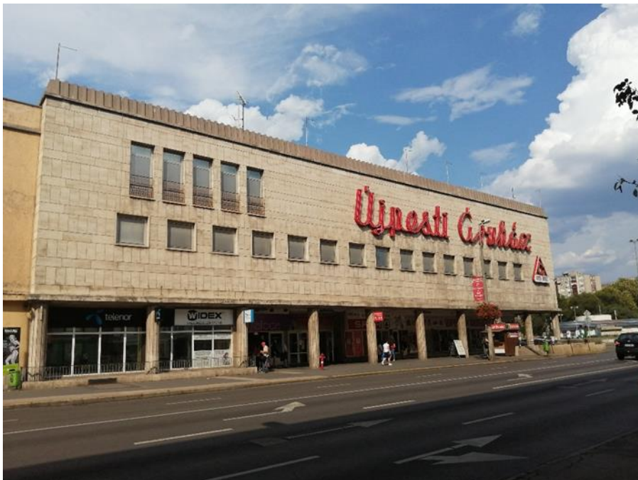
1.3.22. ábra: Újpest ikonikus épülete, az Újpesti Áruház (Forrás: saját készítésű fotó)
