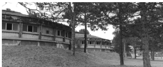
Nagyfelszíni Vízkivételi Mű építményei forrás: saját fotó
