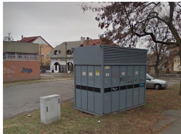
5099 sz. lemez házas 10/0,4 kV-os transzformátor, Béke tér
