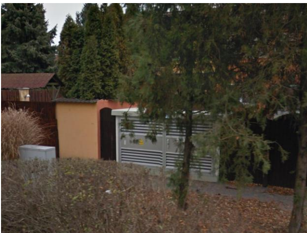
3607 sz. betonházas 10/0,4 kV-os transzformátor, Szabolcska M. u.
