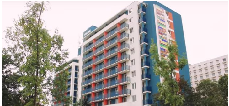
Új erkélyek építésével korszerűsített épület (Püskösdfürdő 38.)
