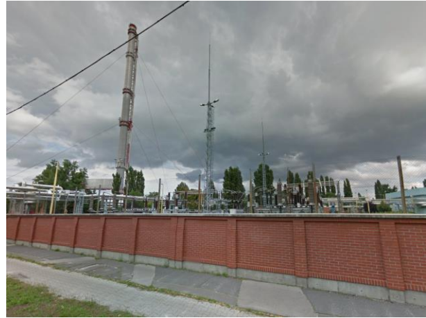
120 kV-os kapcsolóberendezések, Berliini utca
