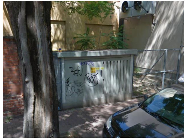
5139 sz. betonházas 10/0,4 kv-os transzformátor, József Attila utca
