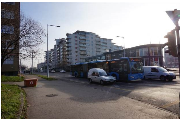
Tél utcai beépítés
