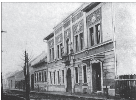
A Munkásotthon egykori épülete
