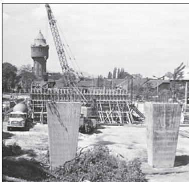
Az Árpád úti felüljáró részben előregyártott elemekből épült. 1974 november 6-án adták át a forgalomnak
