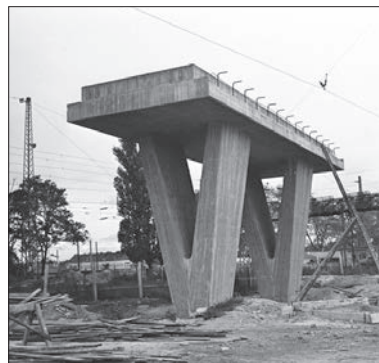
Az Árpád úti felüljáró részben előregyártott elemekből épült. 1974 november 6-án adták át a forgalomnak
