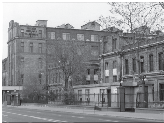
A Tungsram épülete 1990 körül
