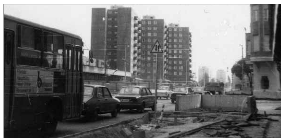
A Bajcsy-Zsilinszky út–Árpád út csomópont 1989 szeptemberében az Újpesti Áruház felől nézve, előtérben az épülő aluljáró-kijárat (A szerző felvétele)
