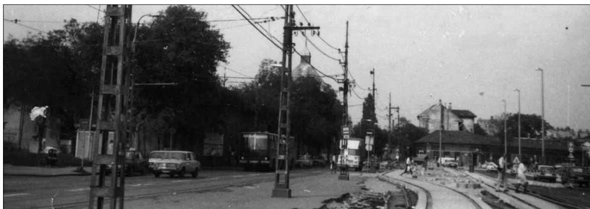
A Bajcsy-Zsilinszky út szélesítése az István térnél 1989 szeptemberének közepén. Balra a régi keramitkockás úttest, jobbra az épülő villamosmegálló és a frissen használatba vett új útpálya látható (A szerző felvétele)
