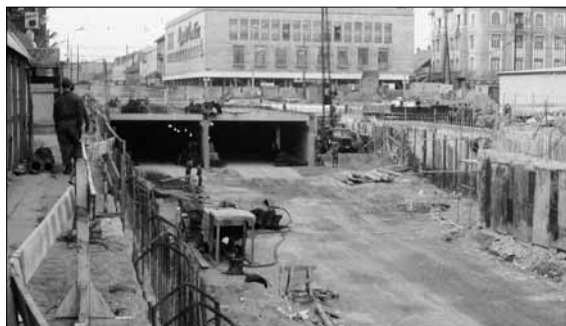
Munkagödör és a megépített aluljárószakasz 1987-ben
