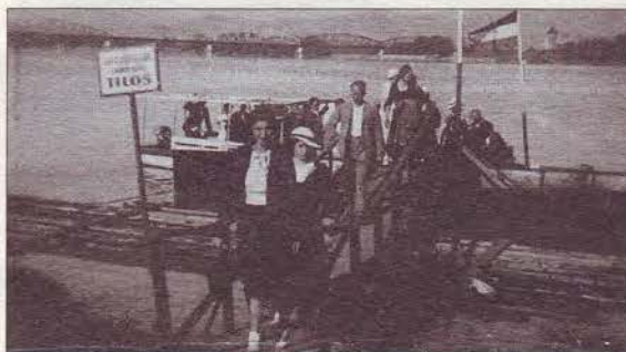
Átkelő motoros érkezett Újpestre. (Háttérben a vasúti híd)
