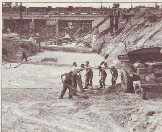
A Béke úti aluljáró átépítése
