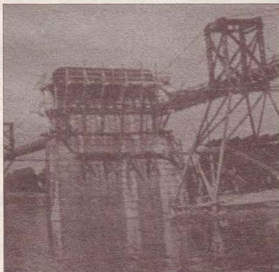
A híd egyik pillére a felújítás idején
