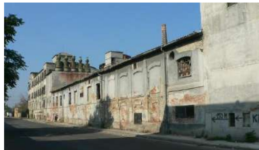
125. ábra: A Zsilip utca a Váci út felől - leromló értékes épületállomány Forrás: http://villamosok.hu/balazs/teher/ipvgk
